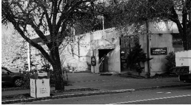
مبنى تنفيذ القانون (Law Enforcement Building)
